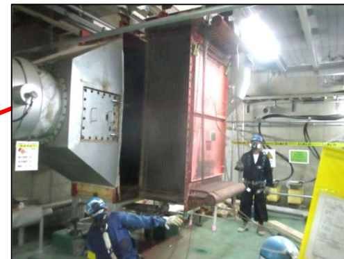
(エレメント撤去)
